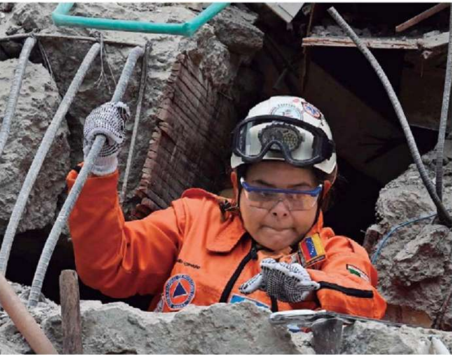
Una rescatasta de los Topos Azteca busca sobrevivientes entre los escombros de un edificio colapsado en Cali, tras el terremoto que sacudió Colombia el lunes.
